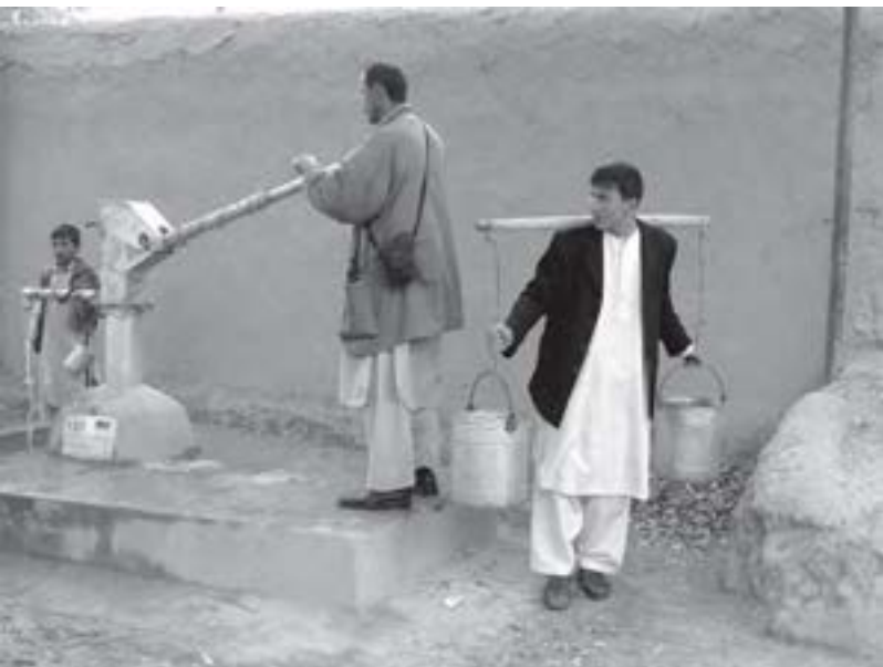
Fertige Brunnenanlage mit Handpumpe Marke „India II“, die relativ wartungsarm ist und in Pakistan hergestellt wird. Alle Brunnen haben ein Blechschild, aus dem hervorgeht, dass die Bundesrepublik Deutschland an der Finanzierung beteiligt war.
